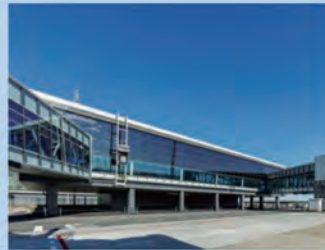
東京国際空港第3ターミナル 国際線サテライト棟 東京都 /2019 年
