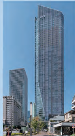
虎ノ門ヒルズ 森タワー 東京都 /2014 年 地上 52 階建 高さ 247m アンボンドブレース 82 基
