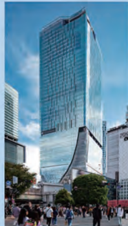
渋谷スクランブルスクエア 東京都 /2019 年 地上 47 階建 高さ 230m アンボンドブレース 292 基
