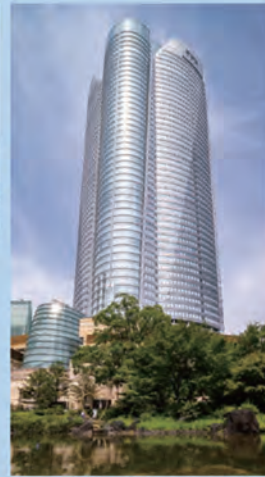
六本木ヒルズ 森タワー 東京都 /2003 年 地上 54 階建 高さ 238m アンボンドブレース 192 基
